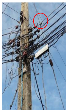
ภาพที่ 1 จุดเสี่ยงในระบบจำหน่ายที่อาจทำให้เกิดอันตรายต่อบุคคลหรือความเสียหายต่ออุปกรณ์
