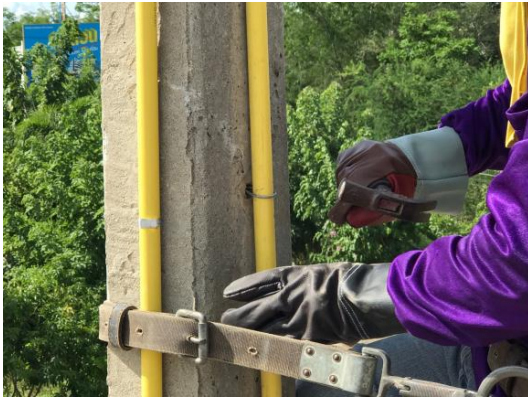
ภาพที่ 12 ภาพการติดตั้งลวดยึดสายดิน ที่ใช้งานจริง
