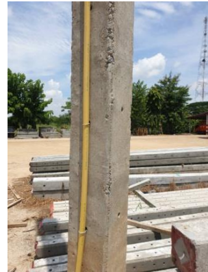
ภาพที่ 12 ภาพการติดตั้งลวดยึดสายดิน ที่ใช้งานจริง
