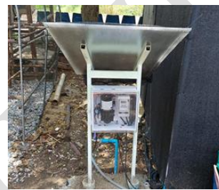
ภาพที่ 5 ระบบรดน้ำโรงเห็ด
