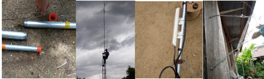
ภาพที่ 4 การติดตั้งเสาอุปกรณ์รับสัญญาณจากสถานีแม่ข่ายและอุปกรณ์กระจายสัญญาณ (ที่มา : ผู้วิจัย)
