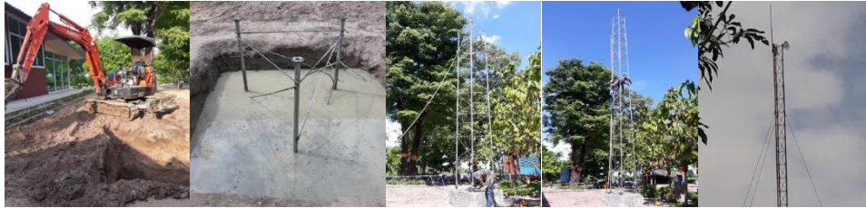
ภาพที่ 2 ก่อสร้างและติดตั้งเสาสัญญาณสถานีแม่ข่าย (ที่มา : ผู้วิจัย)
