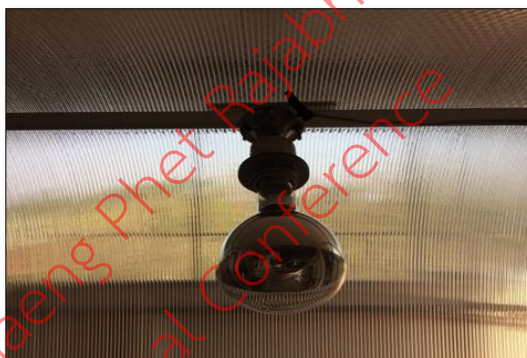
ภาพที่ 5 การติดตั้งหลอดอินฟราเรด
